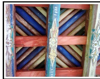
تصویر ۳۳. چینش الوارها و ایجاد نقوش هندسی زیر سقف
